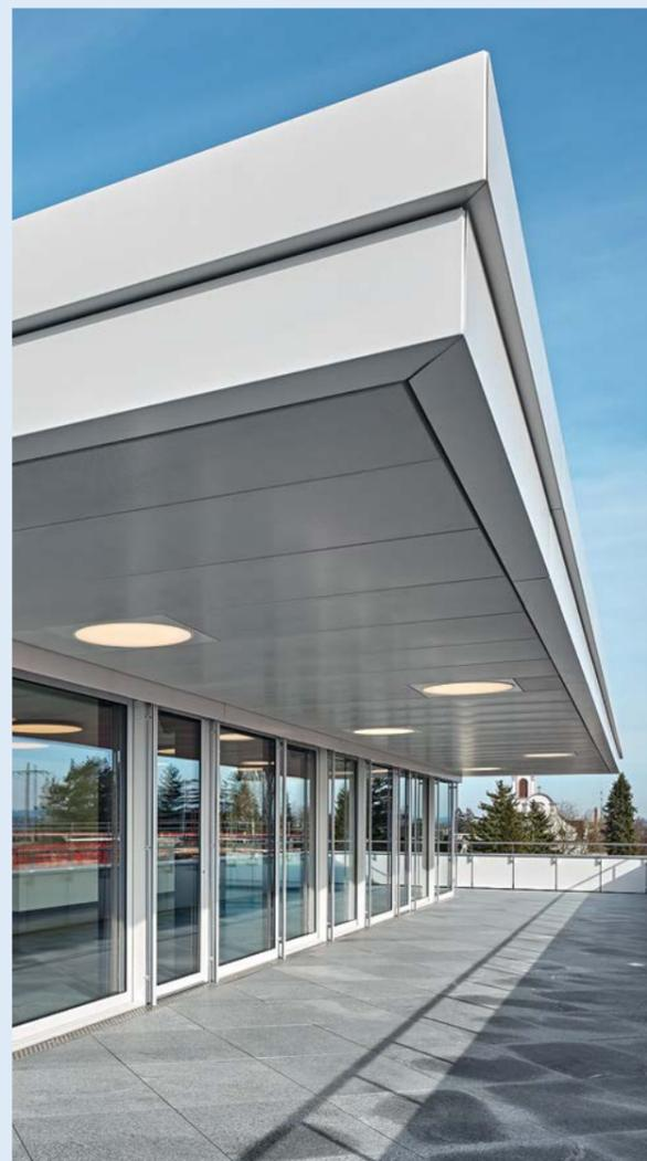
Raffstoren mit Drahtlitzenzuführung, Windsicherung und mehr: dieser innovative Sonnenschutz stellt andere Lösungen in den Schatten.
