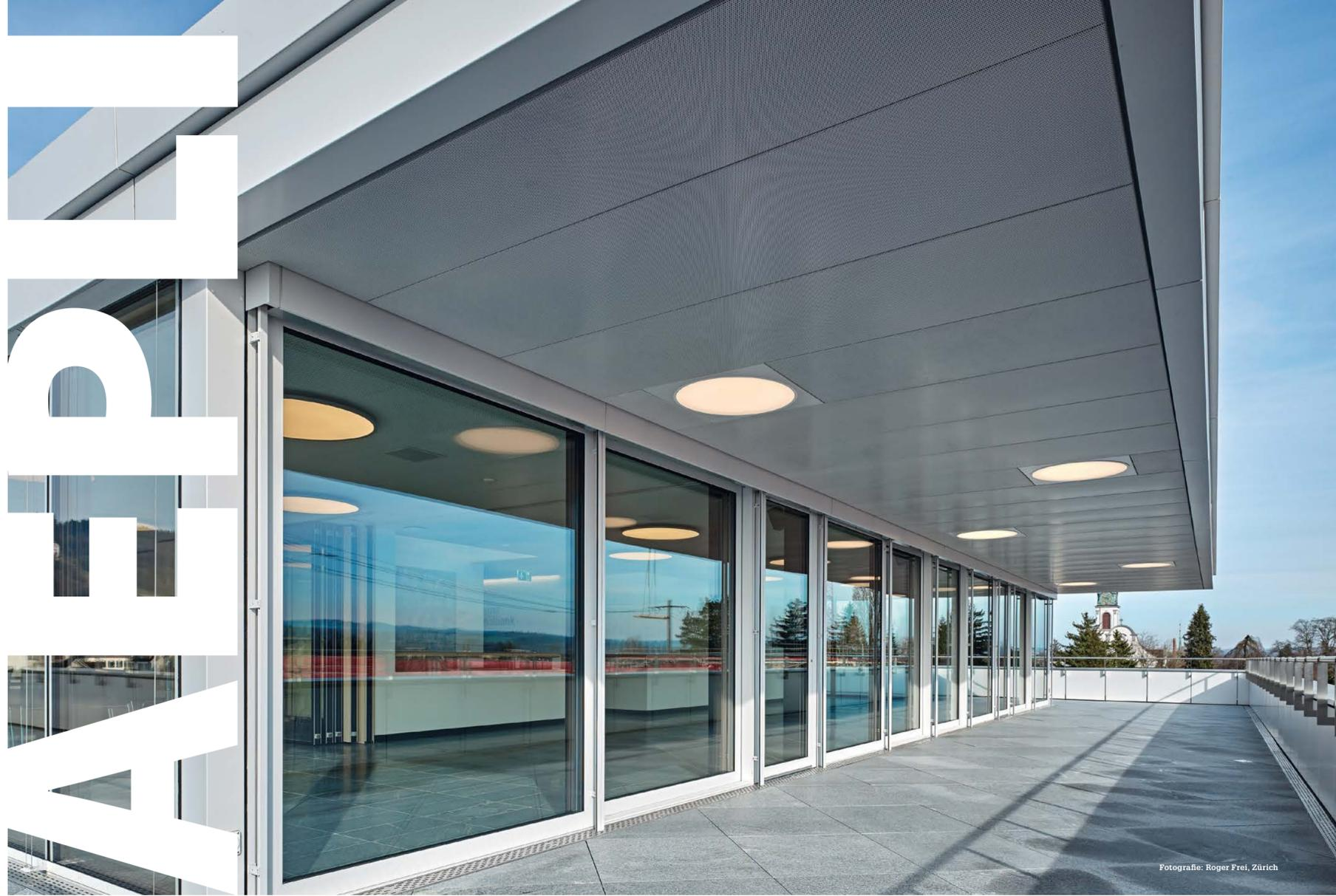
Sicher ist sicher: Das auskragende Attikadach mit 3-fach-Verglasung und Rückmeldekontakten zur zentralen Überwachung.
