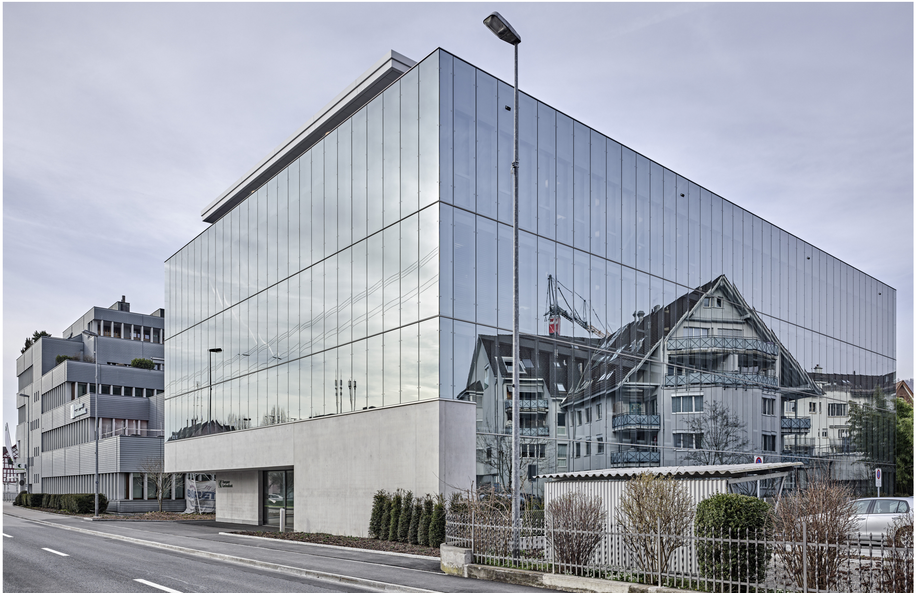
Büro Erweiterung Hauptsitz TKB | Weinfelden Thurgauer Kantonalbank | 137 Arbeitsplätze
