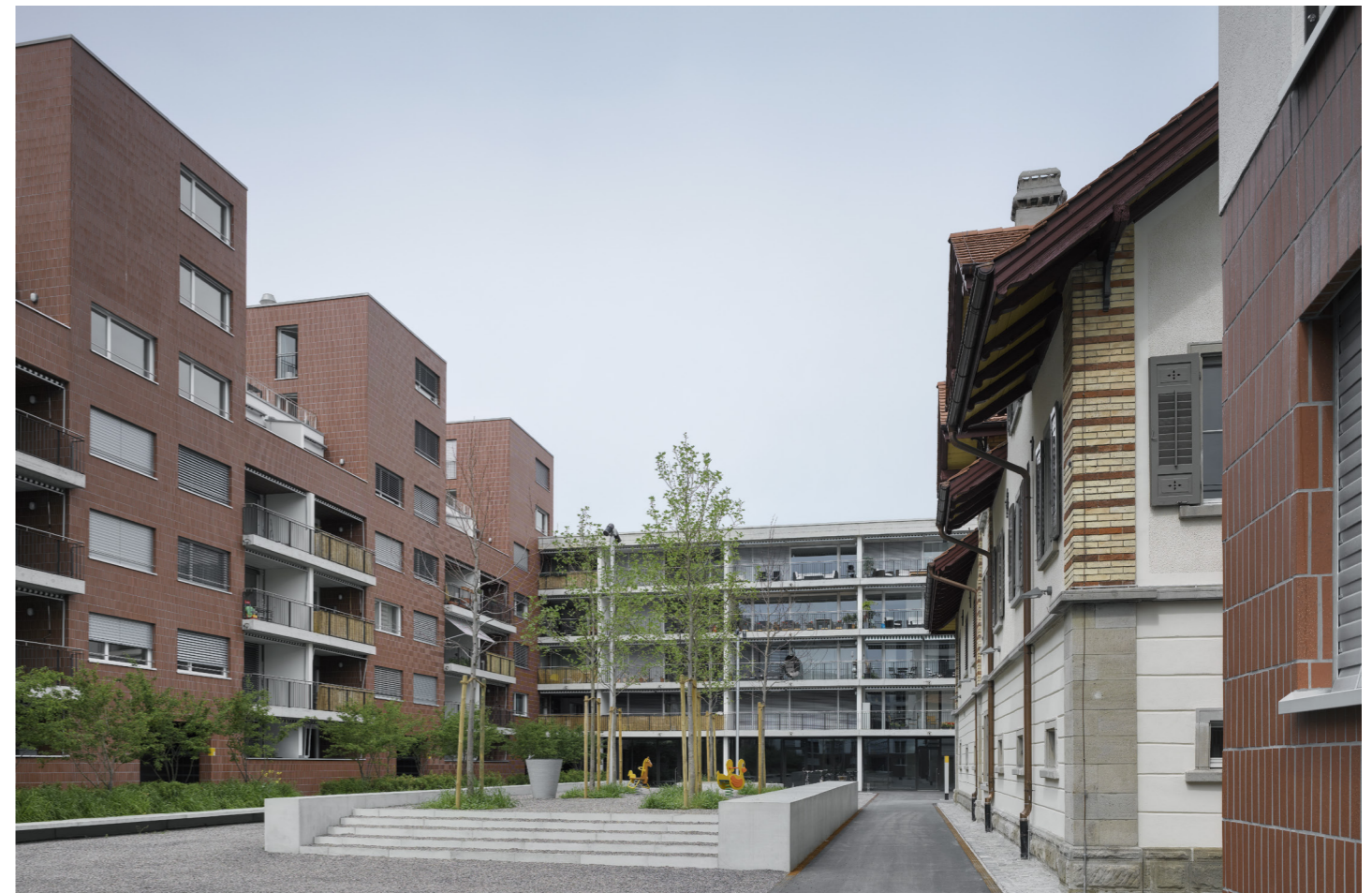
Wohnen Hinterbergstrasse | Zürich Immofonds Immobilien AG | 12 Wohnungen
