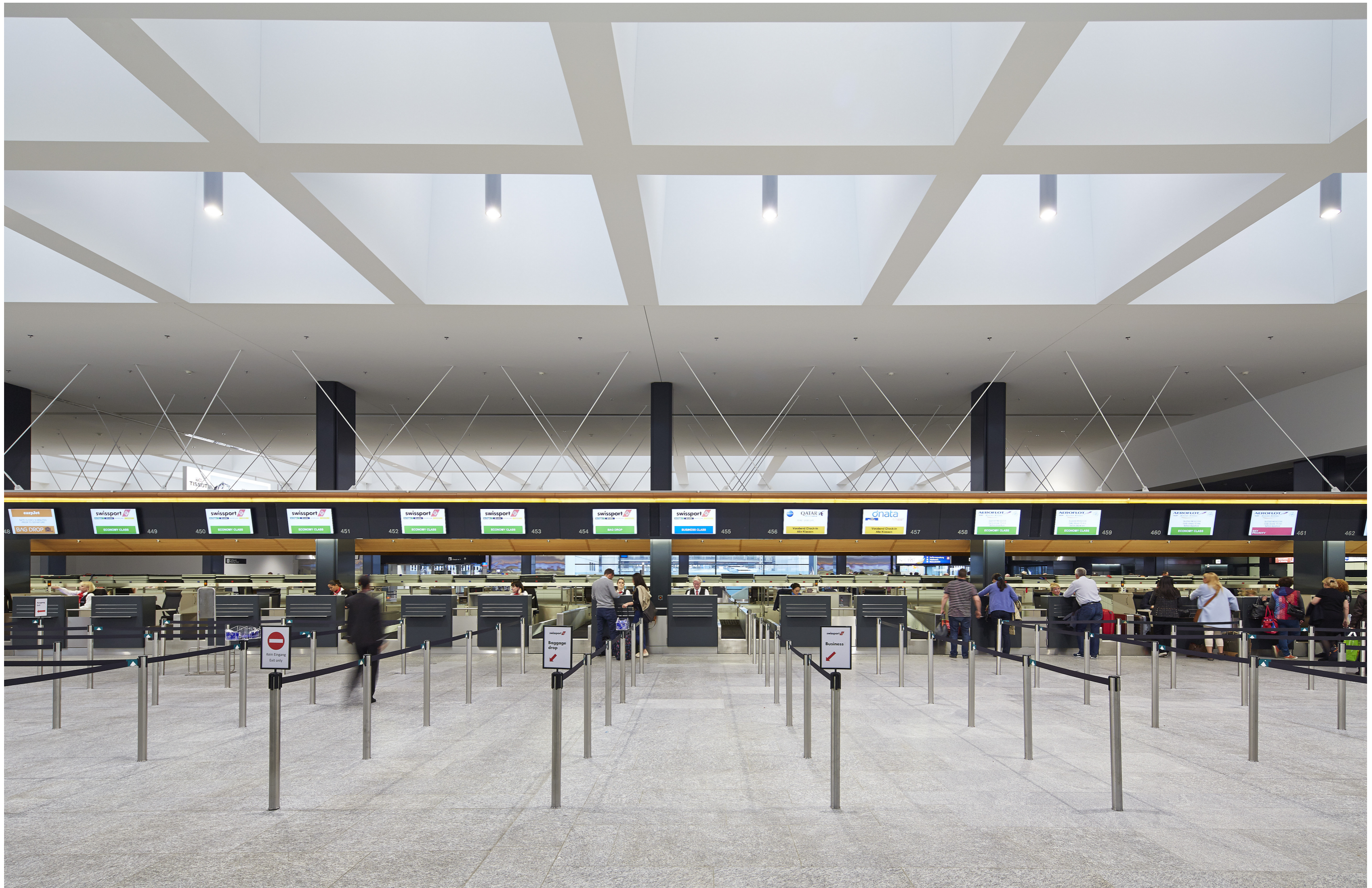
Verkehr Aufwertung Terminal 2 | Flughafen Zürich Flughafen Zürich AG | 104 Check-in-Schalter
