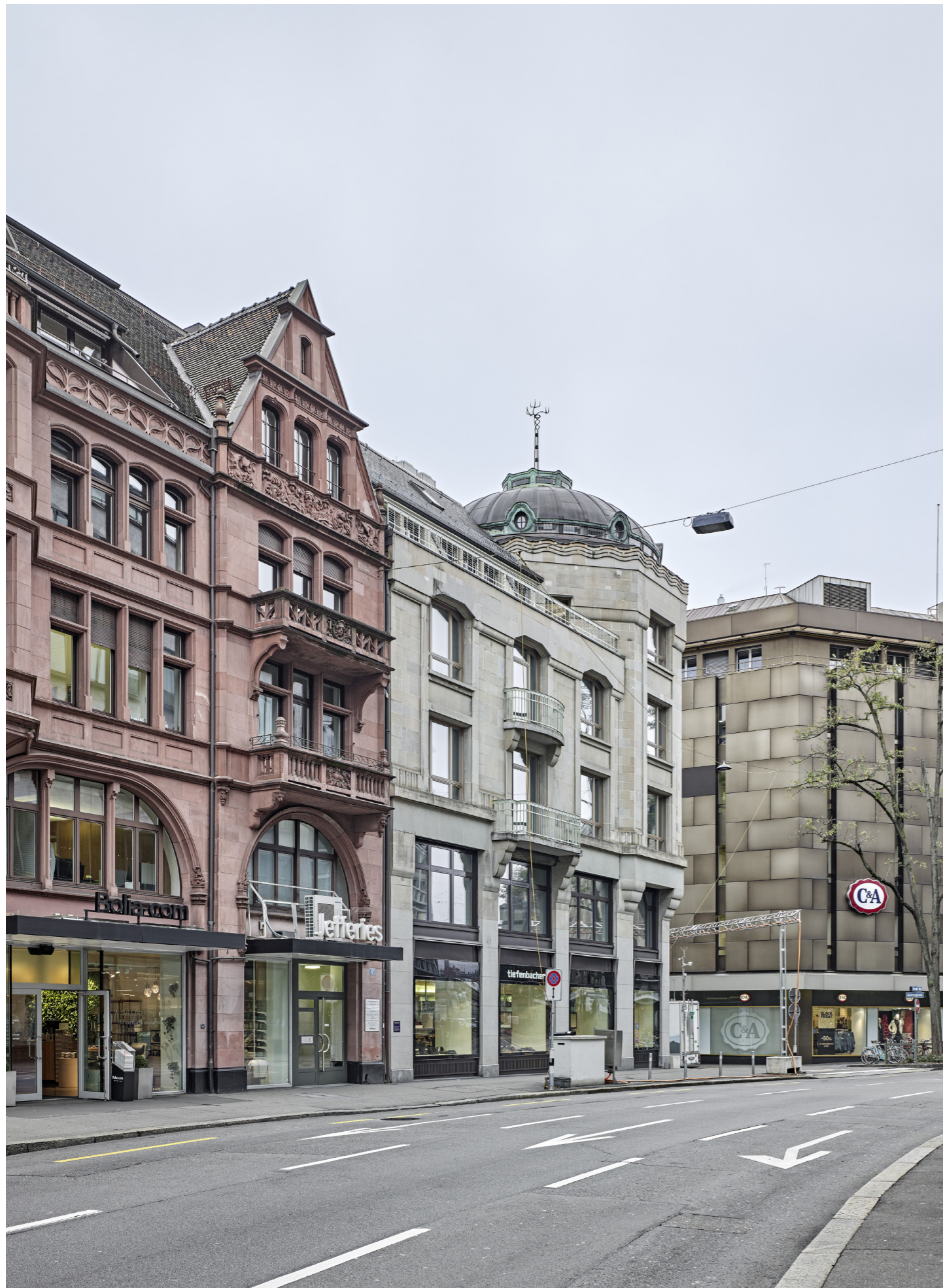
Geschäftshaus Gerbergasse 5 | Zürich PSP Swiss Property AG | 2'204 m 2 Geschossfläche
