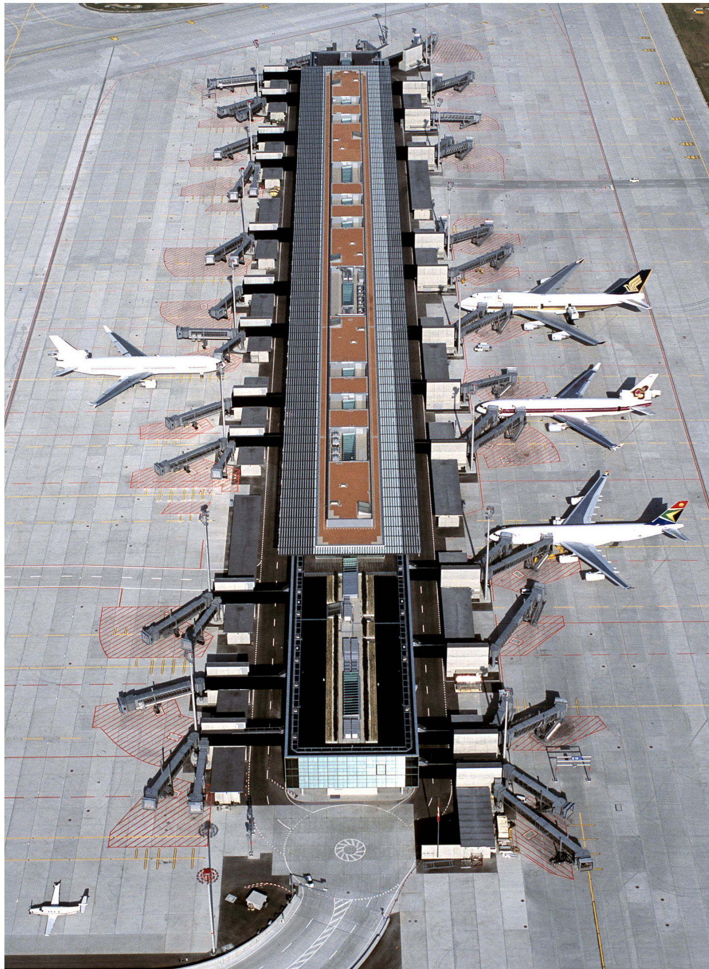
Verkehr Dock Midfield | Flughafen Zürich Unique Flughafen Zürich AG | 27 Flugzeugstandplätze
