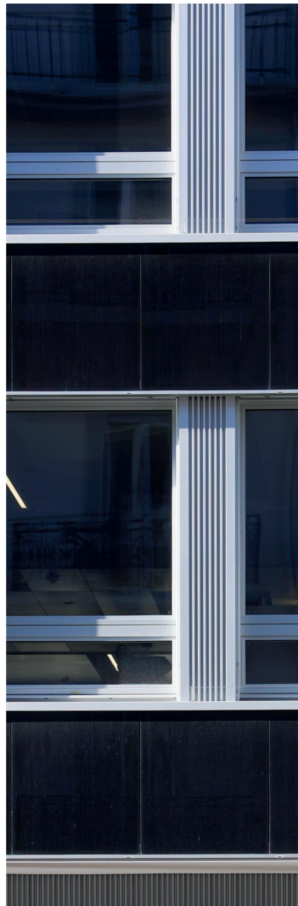
Auch beim genauen Hinschauen sind die quadratischen Solarzellen nicht sichtbar . Nur die offenen Fugen weisen auf die Erneuerung hin.
